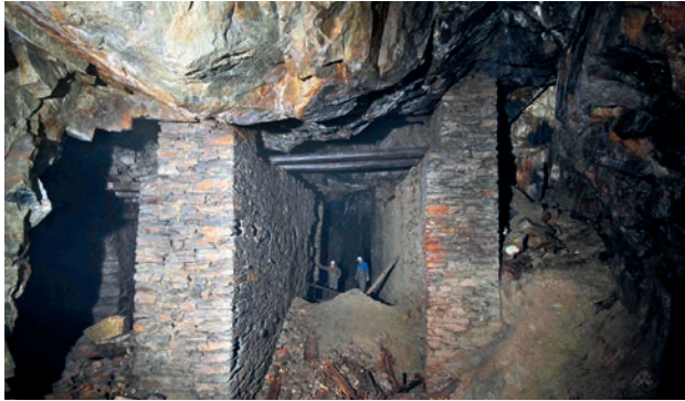
Weitungsbau und ehemalige Radkammer im Bereich der Weißen Zeche der Binge in Geyer
