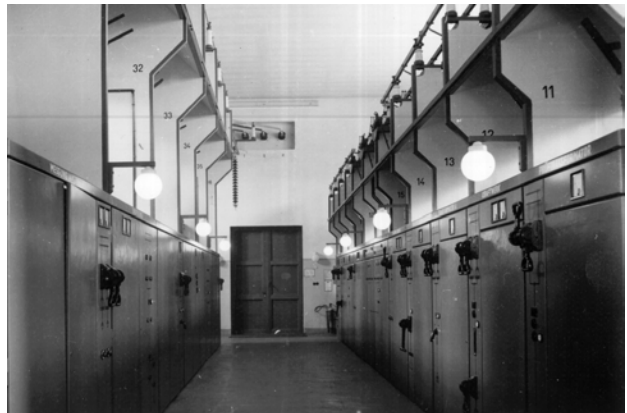
Bild 26: Blick in die Innenraumschaltanlage
