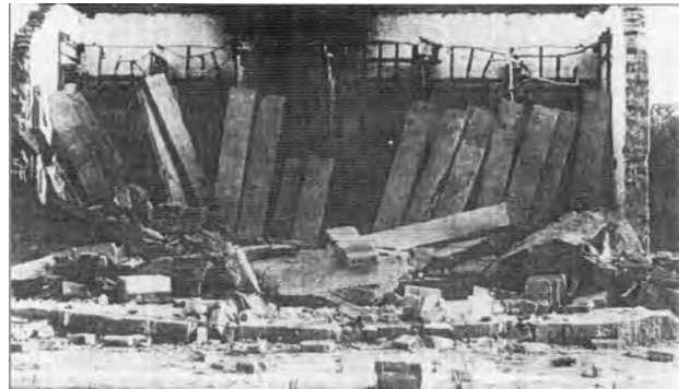
Bild 36: Station Olbersdorf Grube nach der Zerstörung
