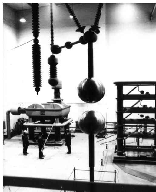
Bild 31: Wechselspannungstransformator, im Vordergrund die Kugelfunkenstrecke
