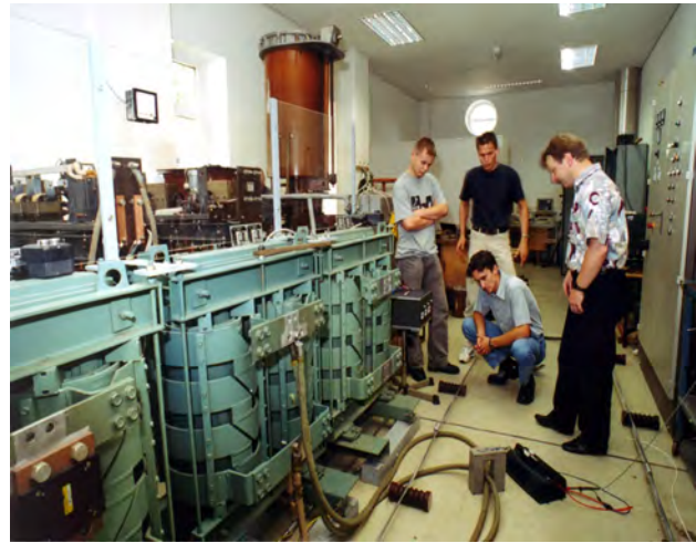
Bild 102: Erwärmungsversuch im Hochstromlabor
