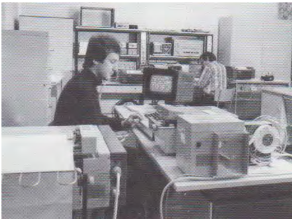
Bild 63: Programmentwicklung am Mikrorechner-Entwicklungssystem MRES 20
