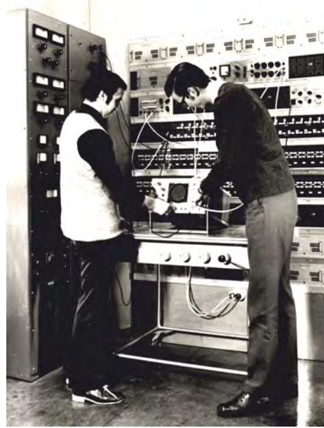
Bild 58: Messungen am 3-poligen Wechselstromnetzmodell (Netzanalysator)
