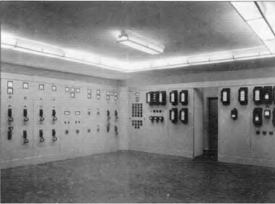
Bild 28: Die Schalt- und Schutzwarte des Lehrumspannwerkes
