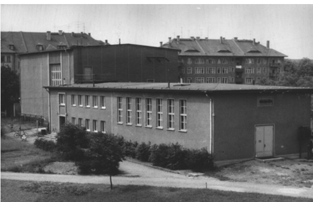
Bild 29: Lehrumspannwerk mit beiden Ausbaustufen und anschließender Hochspannungshalle
