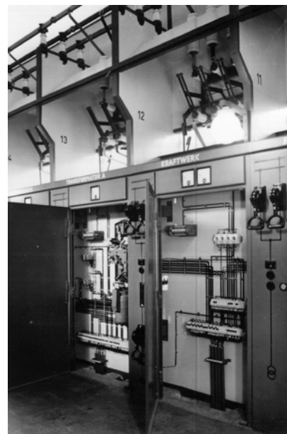
Bild 27: Schaltzellen mit geöffneten Nischenschränken
