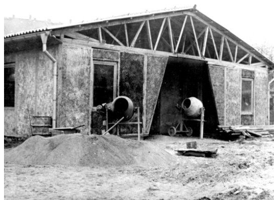
Bild 61a: Gebäude des Applikationslabors Mikroelektronik - in der Bauphase -
