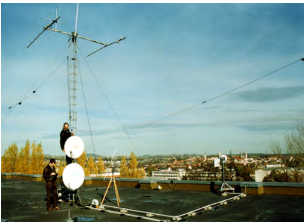
Bild 109: Antennenanlage auf dem Dach von Haus VII mit Blick auf Zittau
