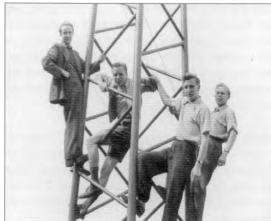
Bild 38: Studenten bei einer Exkursion im Umspannwerk „Glück Auf“ im August 1955
