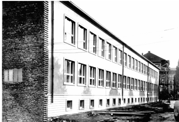
Bild 22: Erster Erweiterungsbau der Fachschule als Anbau in südwestlicher Richtung
