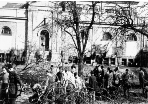
Bild 10: Arbeitseinsatz zur Beräumung des Geländes vor dem alten Websaal
