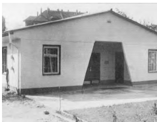
Bild 61b: Gebäude des Applikationslabors Mikroelektronik - nach Fertigstellung -
