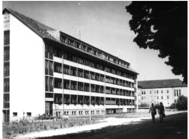
Bild 73 a: Studentenwohnheim D-Block - Gesamtansicht
