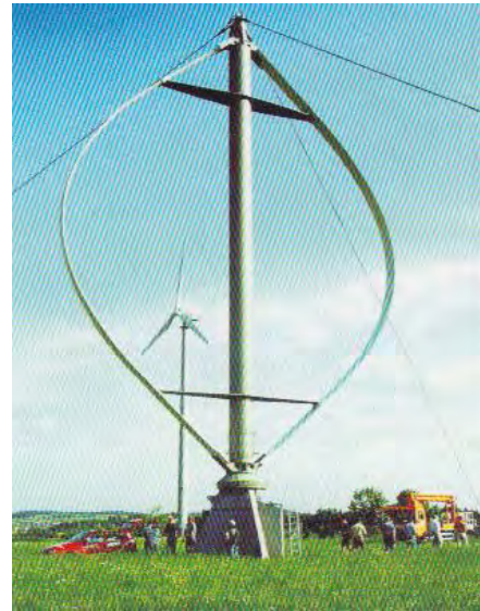
Windkraftanlage der En BW AG
