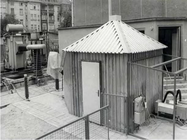
Bild 54: Freiluftversuchsanlage für die Fremdschichtforschung
